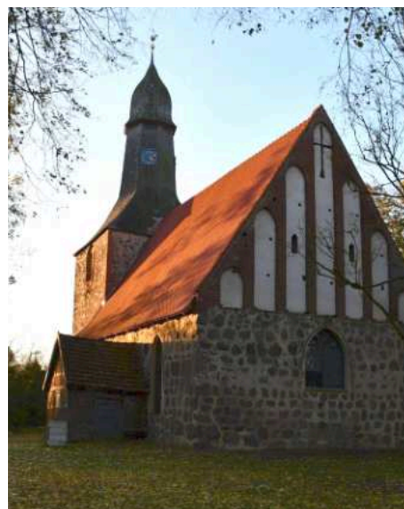
Wieder ein Schmuckstück - die Kladrumer Kirche. Ein langer Atem war nötig, nun ist es geschafft - Dach drauf, Gerüst fort. [Foto: KT]
