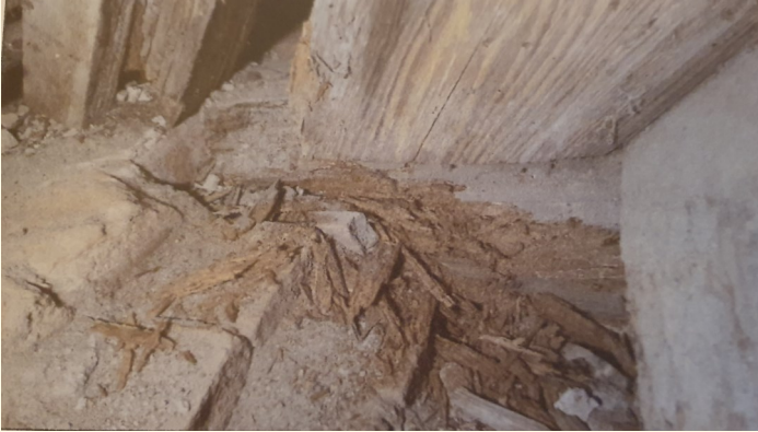
zersetzte Dachbalken
