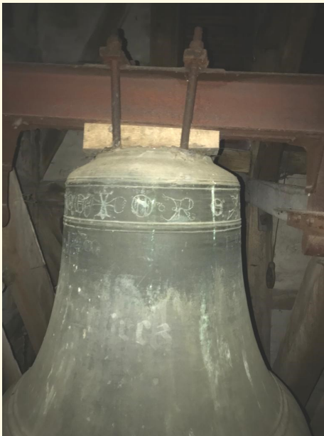
fehlerhafte Glockenaufhängung
