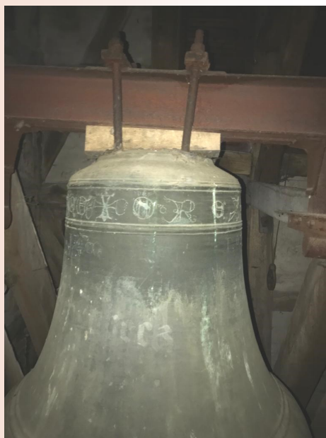
fehlerhafte Glockenaufhängung
